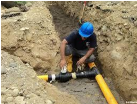
Tuberías para instalación de redes secundarias de Gas Natural
