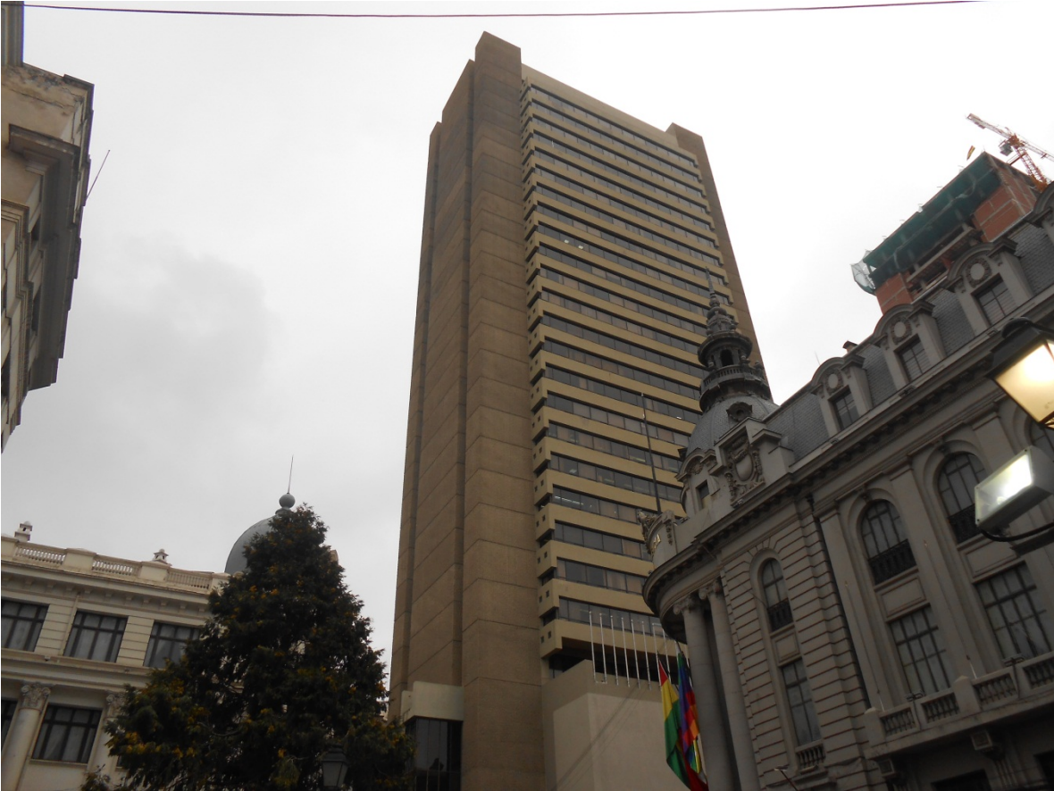
Edificio del Banco Central de Bolivia (BCB), en el centro de la ciudad de La Paz.
