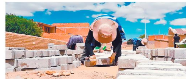
Obreros en una obra de enlosetados. Foto: Min. de Planificación
